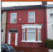
Udderdale Road L15
